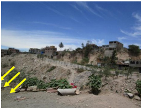
Imagen 08: Problemas encontrados en el área identificada del proyecto
